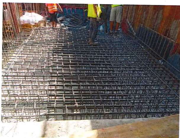
UČS 11, Armovanie a debnenie dna tubusu, podchod
