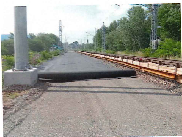
UČS 01, Rozprestretie štrkodrvy a geotextílie
