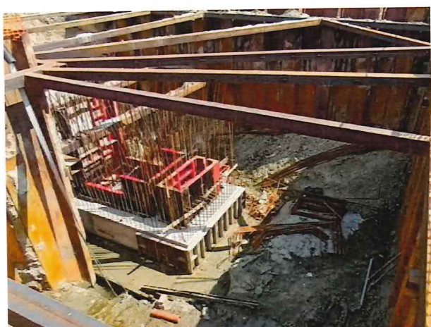
UČS 11, Oddebnenie a izolácia výťahovej šachty, podchod
