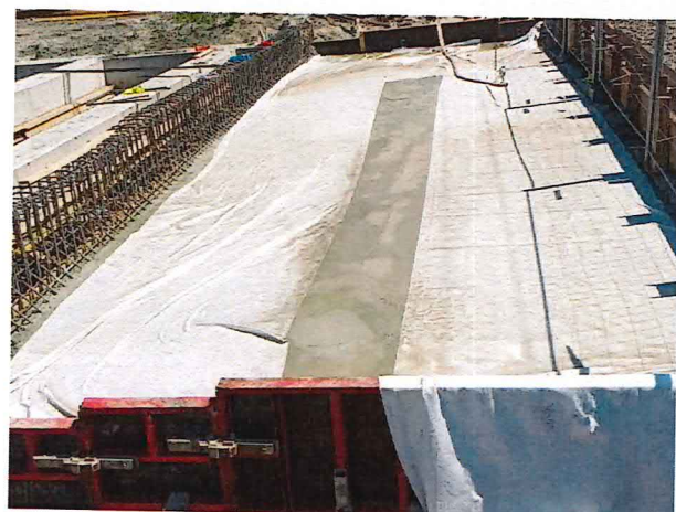
UČS 11, Betonáž mostovky, podjazd
