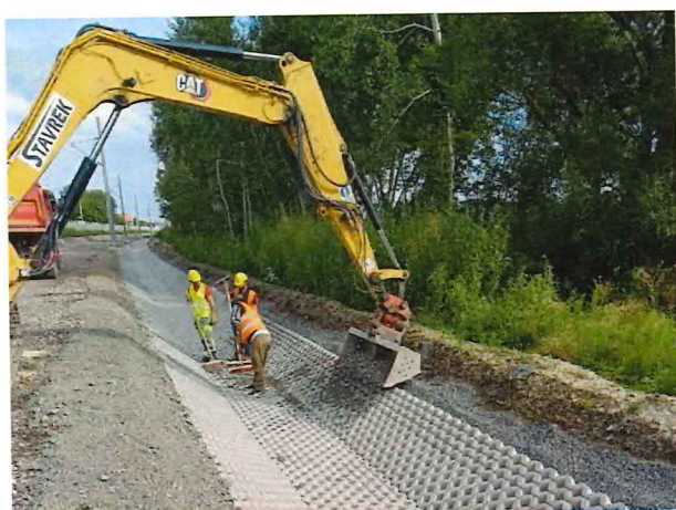
UČS 10, 11, Odkopy rýh a realizácia spevnených priekop
