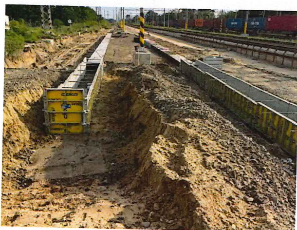
UČS 02, Betonáž základového pásu, nástupisko
