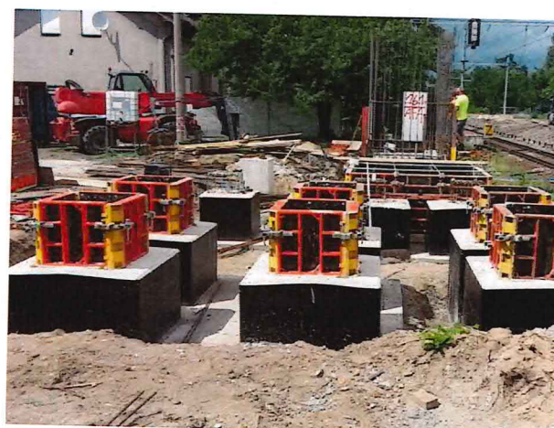
UČS 01, Armovanie a debnenie výťahových šácht a druhý stupeň základov, lávka pre cestujúcich
