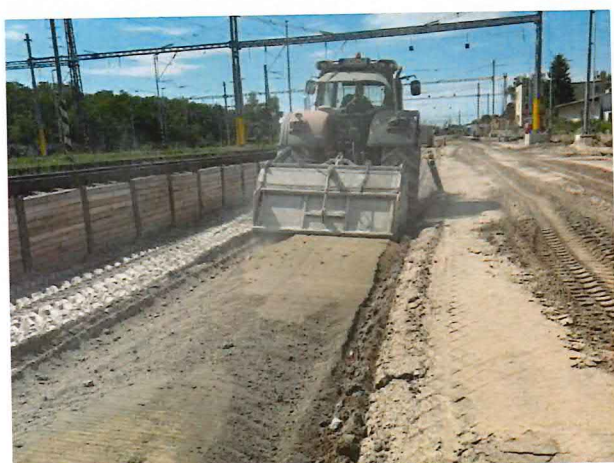
UČS 02, Príprava a stabilizácia zemnej pláne
