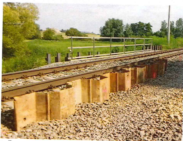
UČS 01, Realizácia záporového paženia, priepusty a mosty
