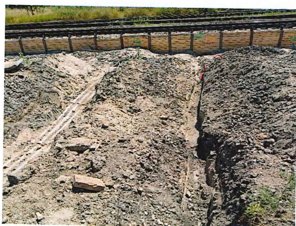
UČS 02, Odkopávanie starých kábelových trás
