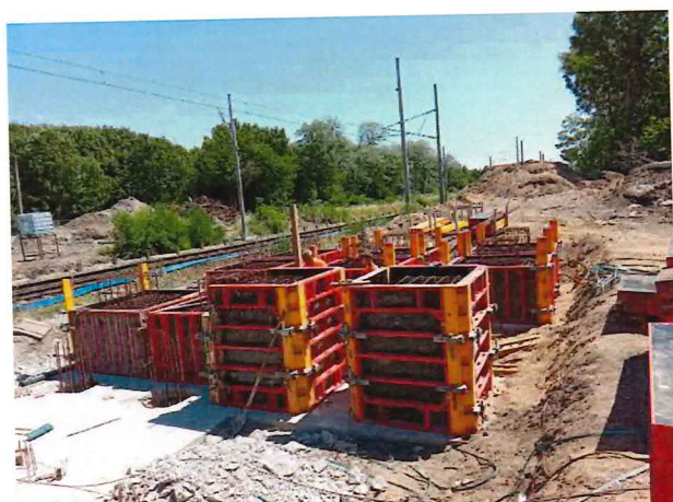
UČS 01, Armovanie a debnenie základov, lávka pre cestujúcich
