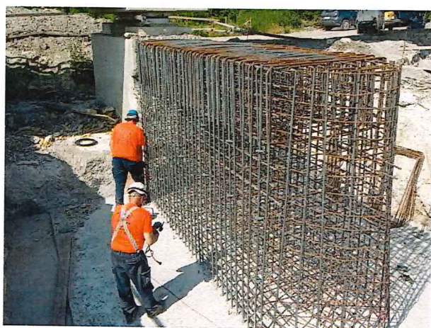
UČS 12, Armovanie a debnenie drieku mosta
