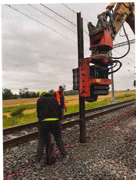
UČS 01, Realizácia záporového paženia
