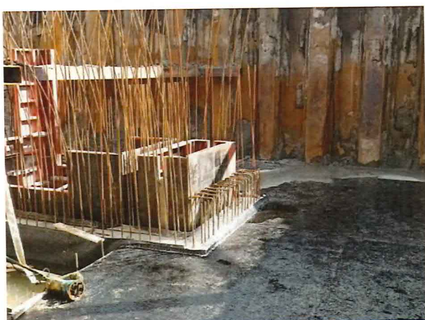
UČS 11, Penetračný náter a izolácia, podchod
