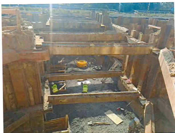
UČS 02, Podkladná vrstva pod podkladový betón, podchod
