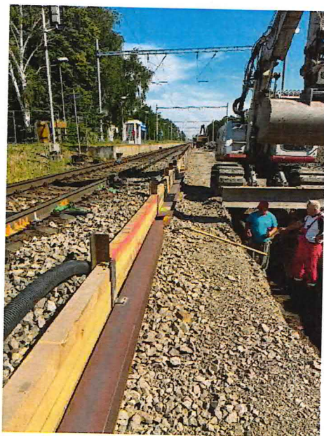
UČS 01, Realizácia záporového paženia a odkop železničného spodku
