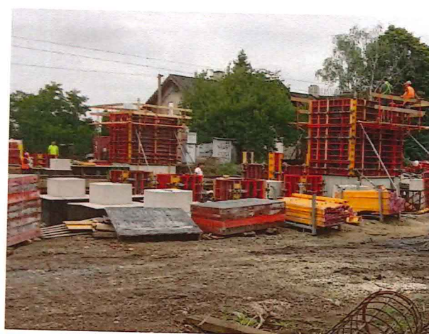
UČS 01, Armovanie, debnenie a betonáž výťahových šácht, lávka pre cestujúcich
