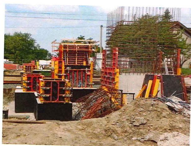
UČS 01, Armovanie, debnenie a betonáž výťahových šácht, lávka pre cestujúcich
