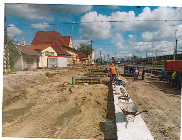
UČS 02, Armovanie a debnenie základov pre prístrešky
