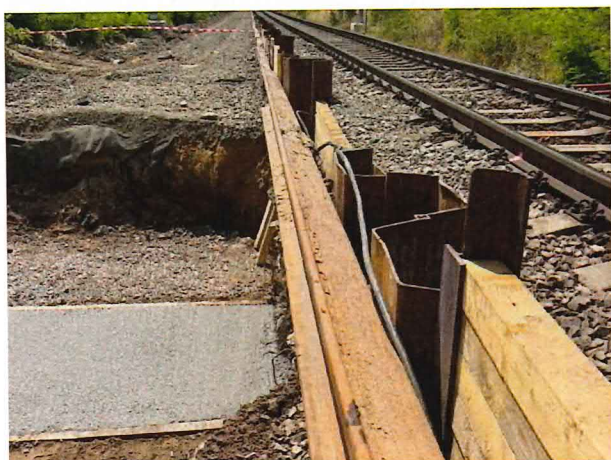
UČS 01, Búranie betónov, úprava podložia a podkladový betón, priepust
