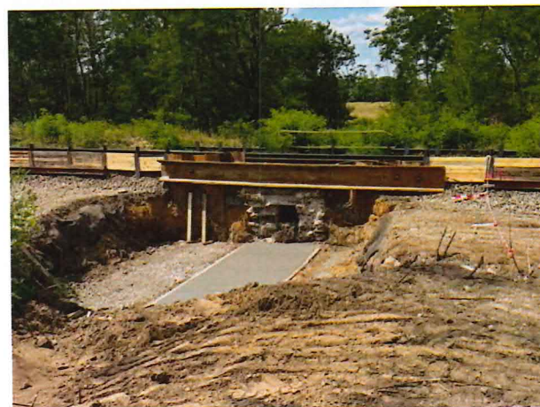
UČS 01, Búranie betónov, úprava podložia a podkladový betón, priepust
