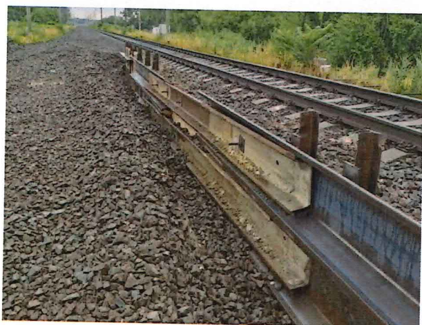
UČS 01, Realizácia záporového paženia a odkop železničného spodku
