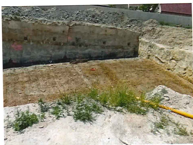
UČS 11, Armovanie a betonáž podkladnej dosky, podjazd
