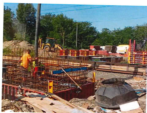
UČS 01, Armovanie a debnenie výťahových šácht a druhý stupeň základov, lávka pre cestujúcich
