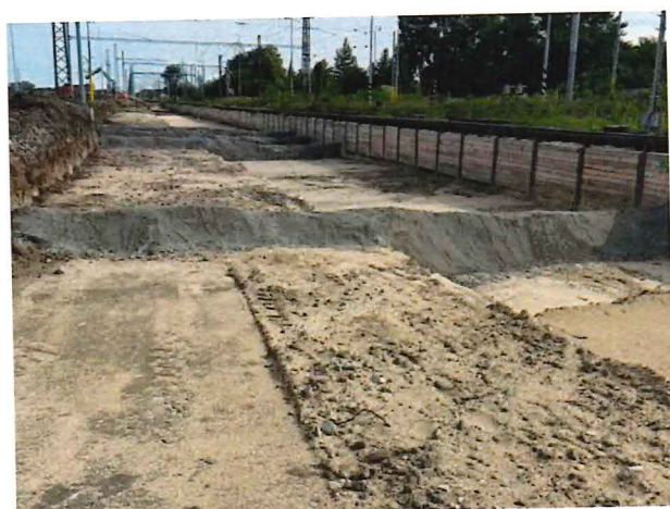
UČS 02, Ochrana jestvujúcich kábelových trás suchým betónom
