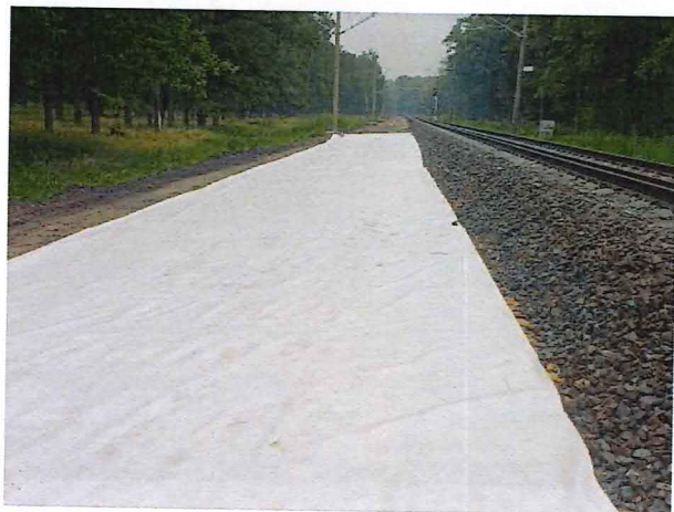
UČS 10, Rozprestretie geotextílie a štrkodrvy, zriadenie PŽS
