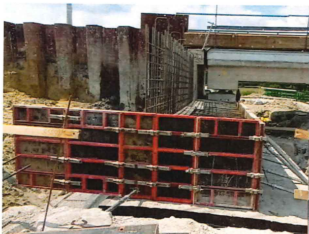
UČS 12, Armovanie, debnenie a betónáž základu
